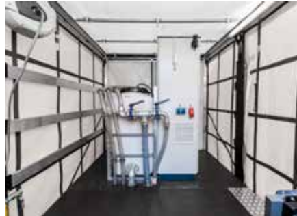
Schaltschrank für Steuerung und Fernwartung
